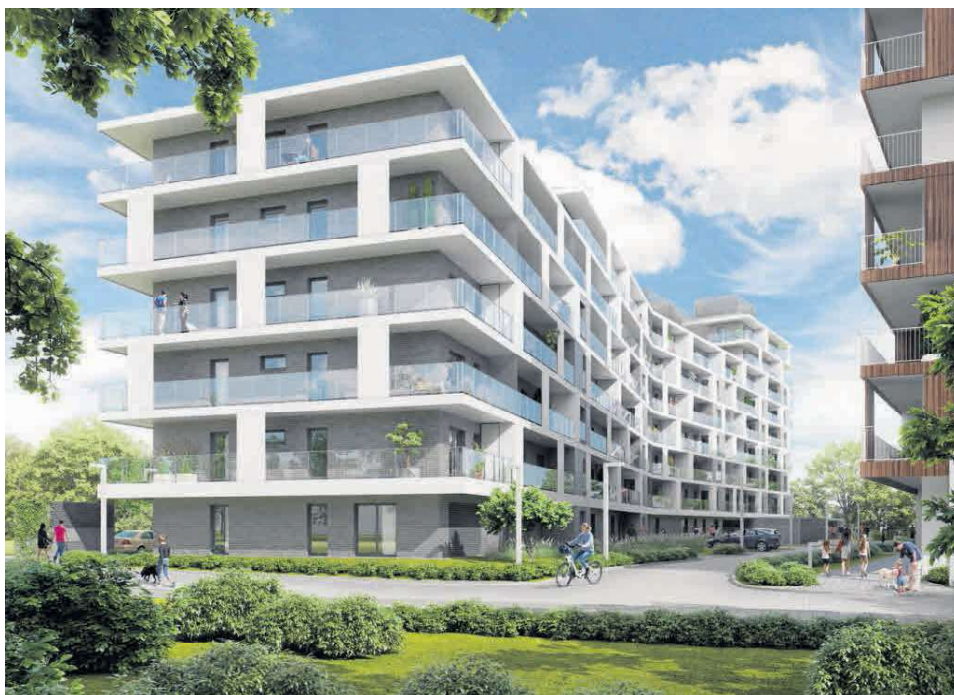
▶ Na osiedlu Wybrzeże Reymonta znajdziemy wygodne mieszkania. Budynek położony w pobliżu rzeki otaczają tereny rekreacyjne
